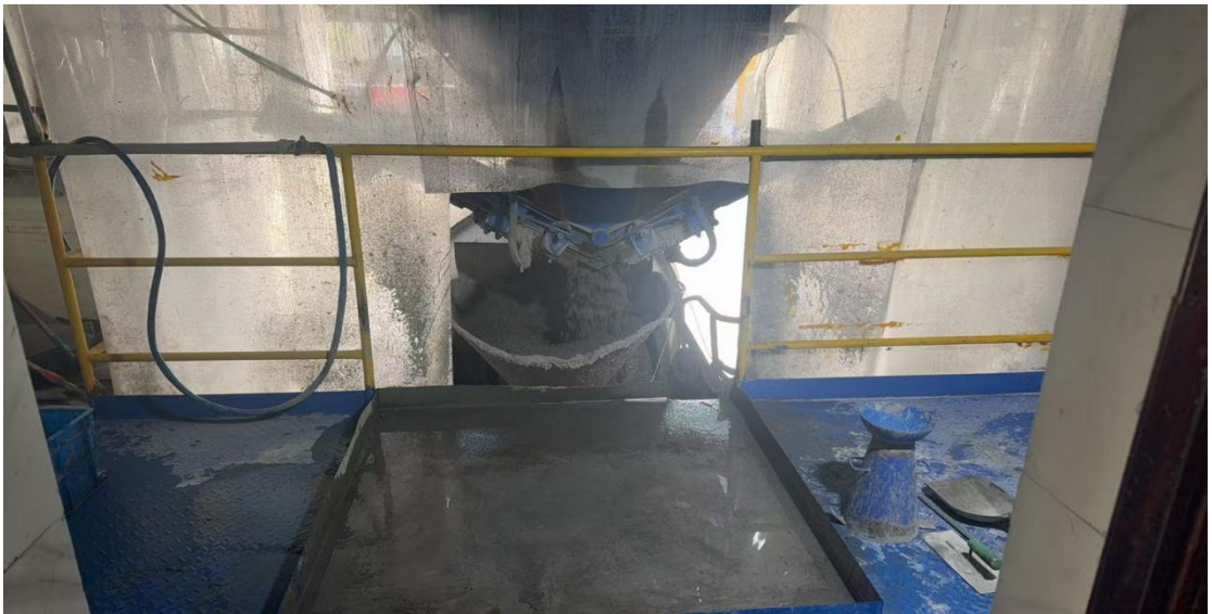
图 11.2 混凝土自动放料防溢出及清洗料斗
