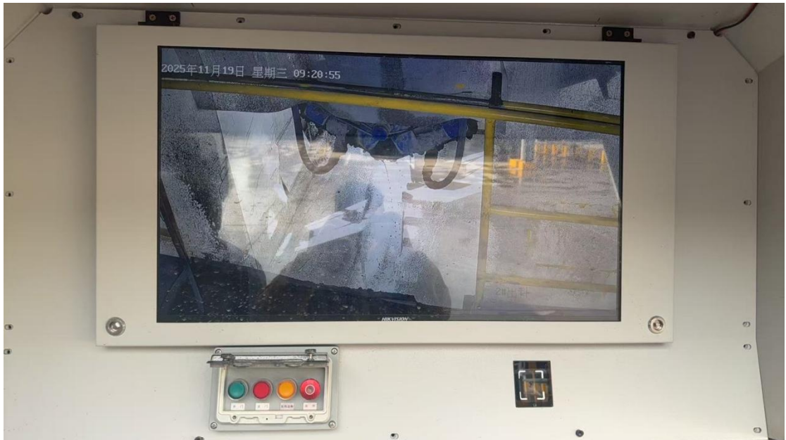
图 11.1 搅拌楼边驾驶员混凝土生产扫码处
