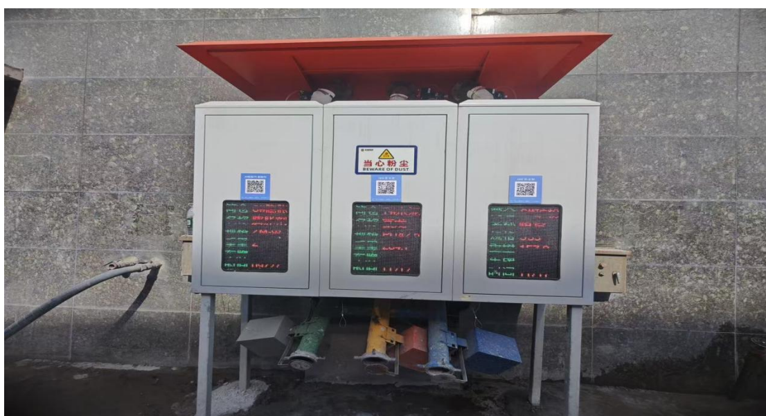
图 13.2 粉料卸车品种、仓位显示及连续取样器（在箱里面）
