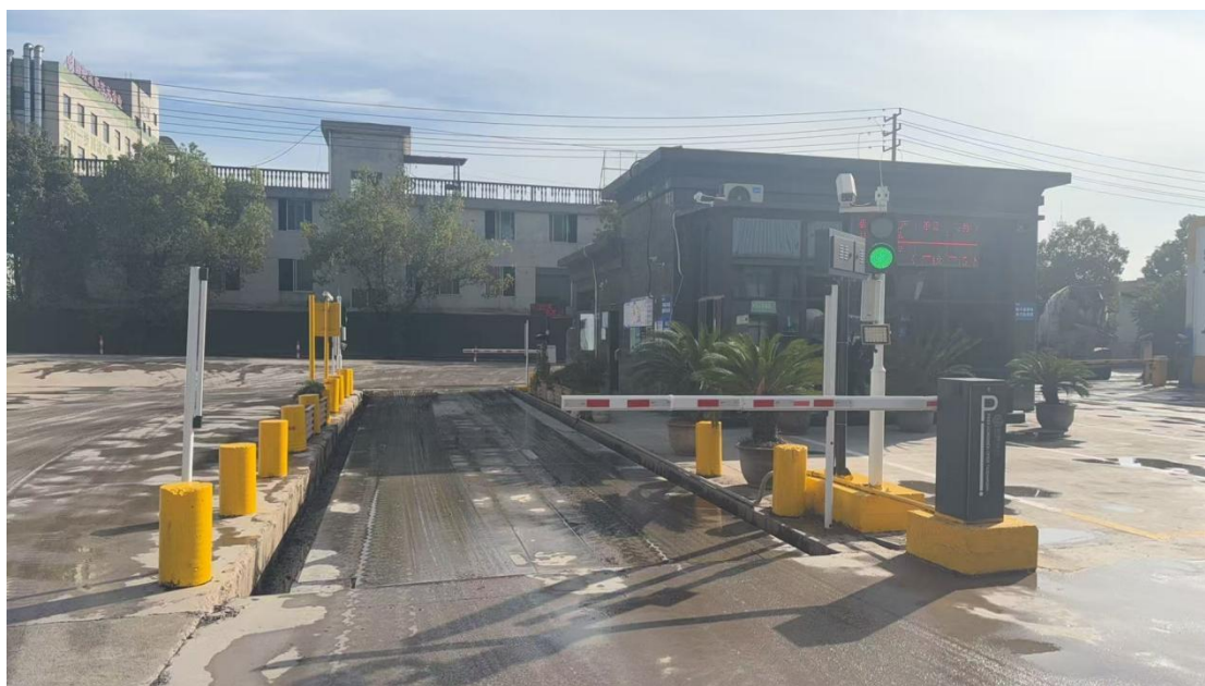
图 13.1 自动过磅系统（含车辆识别系统）
