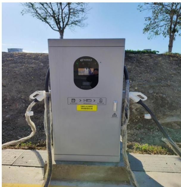
图 9.2 搅拌车充电设备
